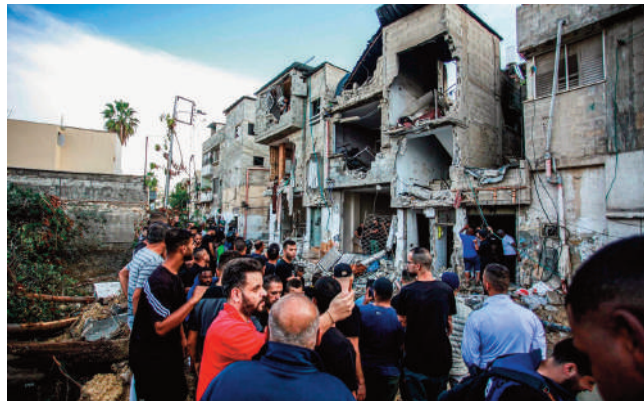
Palestyńczycy dokonują inspekcji uszkodzonego budynku po nalocie izraelskiej armii w mieście Tulkarm na okupowanym Zachodnim Brzegu.
